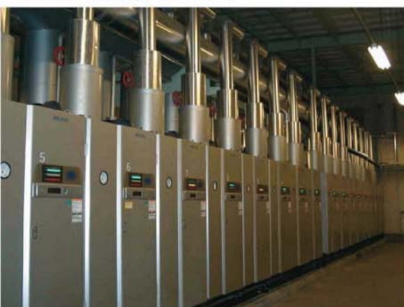
▲天然ガスに燃料転換したボイラ
